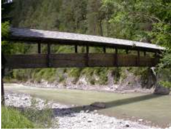
Brug over de Lech (foto LVR)
