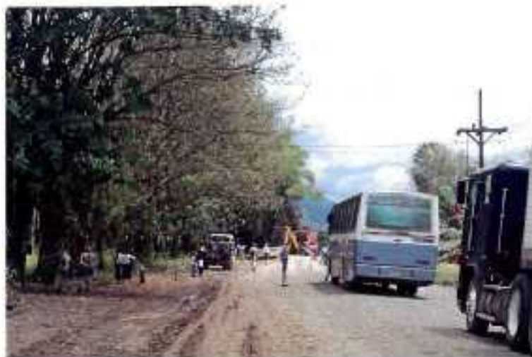
Werk in uitvoering (foto Marjan Langeveld)
