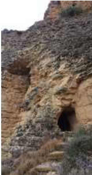
Hier is een inkijk in het aquaduct mogelijk
